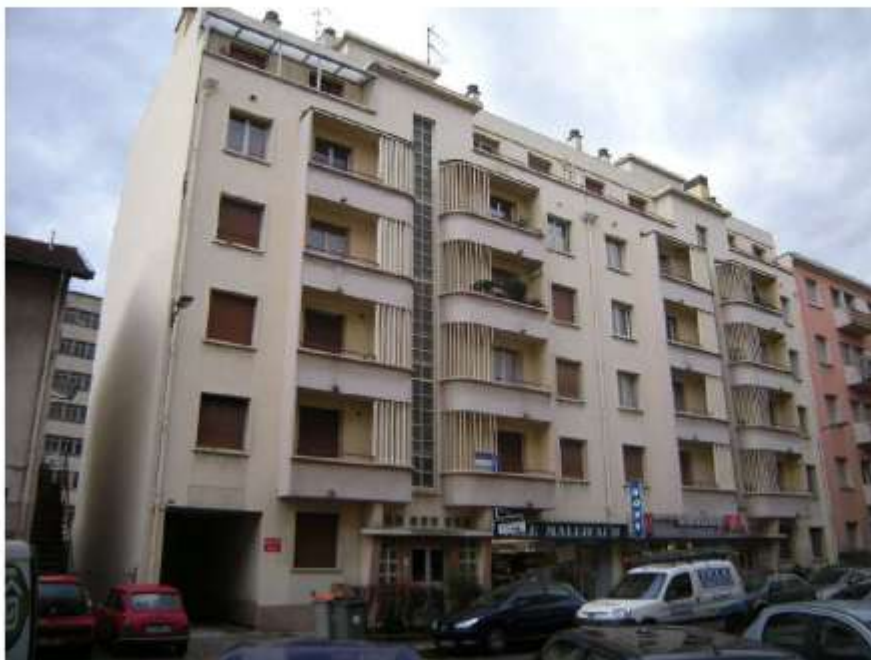
Façade côté rue (nord), avec les halls d'entrée et les cages d'escalier particulièrement vitrées. À gauche, au rez-de-chaussée, un porche permettant d'accéder à l'arrière du bâtiment.
